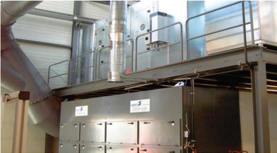
Mechanische Bearbeitung – Kühlschmierstoffaerosole – 78.000m<sup>3</sup>/h
