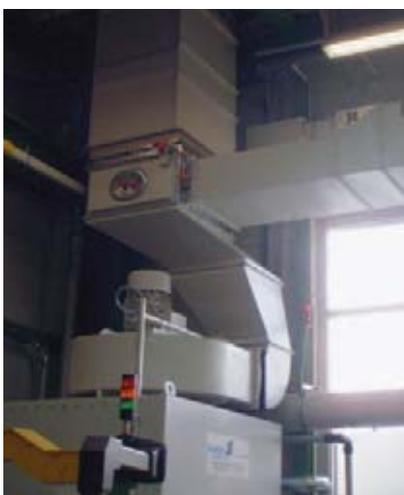
Wechselschaltung Umluft/Abluft bei einem Handte MF-Trockenfilter
