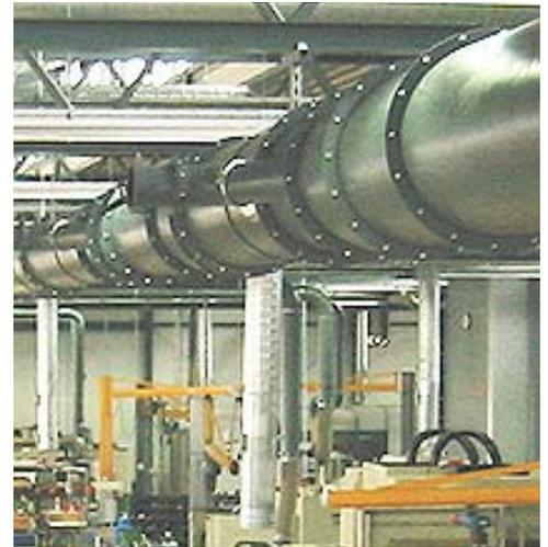
Zuluft bodennah – Schichtströmung
