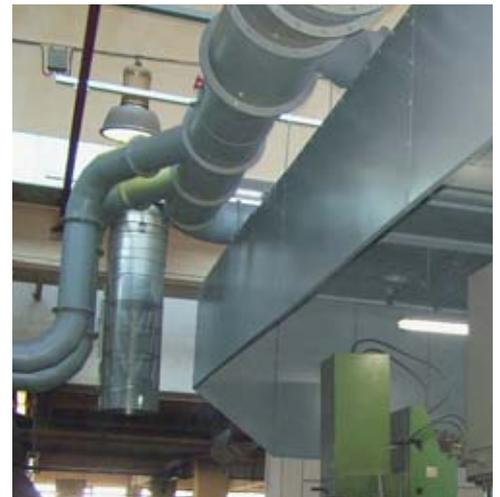
Zuluft in 3 m Höhe – Schichtströmung
