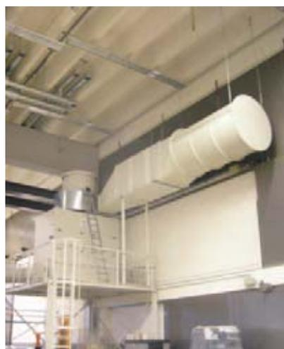
Umluftführung bei einem Handte Emulsionsnebelabscheider
