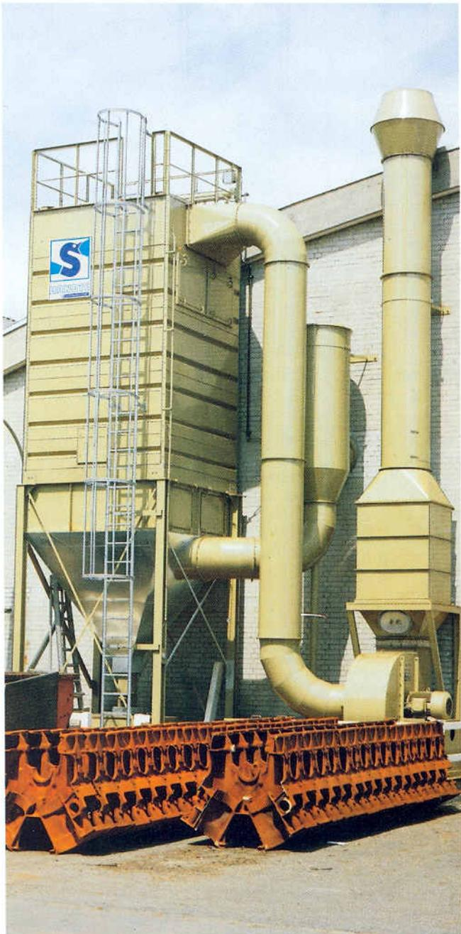
Absaugung einer Strahlanlage für Aluminiumteile. Absaugmenge 20.000 Bm<sup>3</sup>/h mit Druckentlastungsflächen und Bersttopf.
