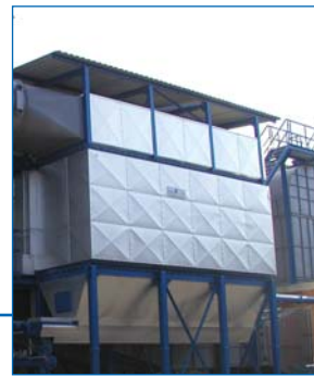
Absaugung Drehtrommelofen Alu-Recycling Luftmenge: 90.000 Nm 3 /h — Temperatur 170 °C
