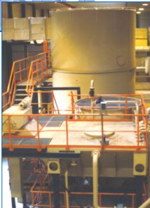
Absaugung Phenole in der Kokillengießerei Volumen: 1.000.000 Bm 3 /h
