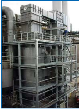
Absaugung Gießanlagen/Strahlanlagen Volumen: 240.000 Bm 3 /h
