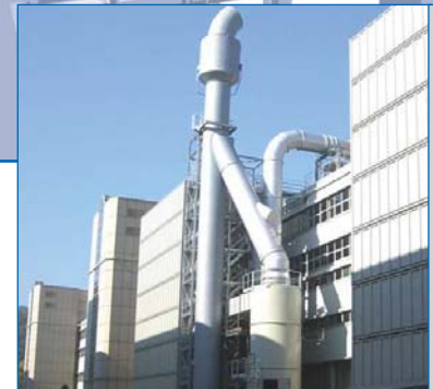
Absaugung Alu-Gießerei Volumen: 120.000 Bm 3 /h
